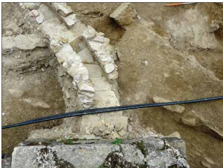
Sl. 15 Odvodni kanal preko groblja sa sjeveozapadne strane
