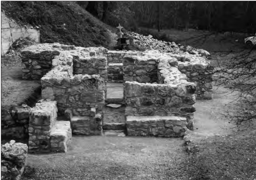
Ћелије – изглед зидова цркве Св. Луке после конзервације
